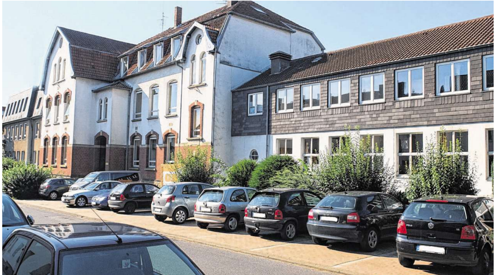
Das Schulgebäude in der Kaiserstraße in Eilendorf soll Heimat des Montessori-Lernzentrums mit Grundschule und Kindertagesstätte werden.
